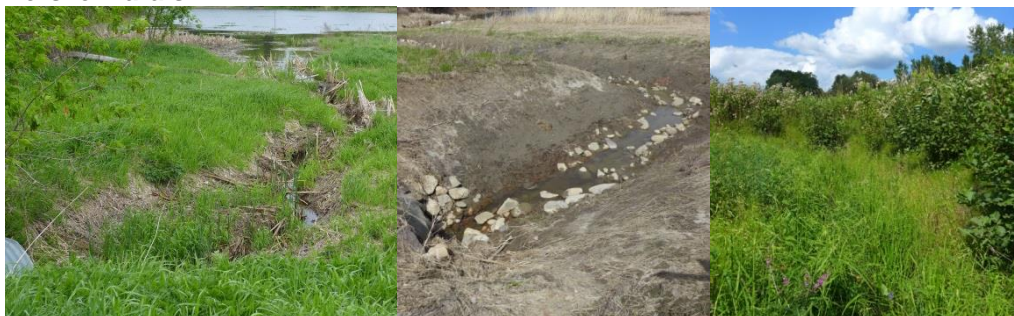
15 mai 2013 (avant travaux)
