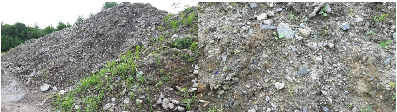
Photos du matériel de remblais trié qui sera utilisé pour la fabrication de la digue composée d'argile de terre et de cailloux
