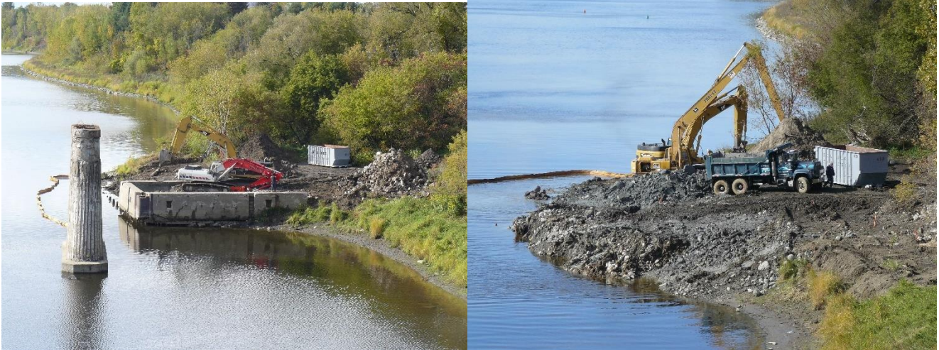
Photos du démantèlement du quai gouvernemental à Odanak en octobre 2009
