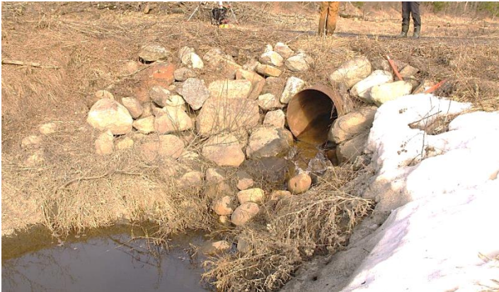
Photo prise le 10 avril 2013 Vue sur l'aval du ponceau à partir du chenal Tardif
