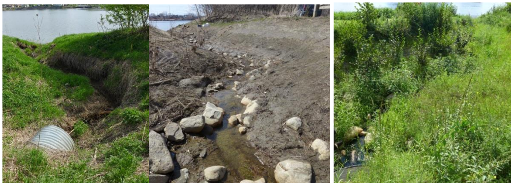
9 mai 2013 (avant travaux)
