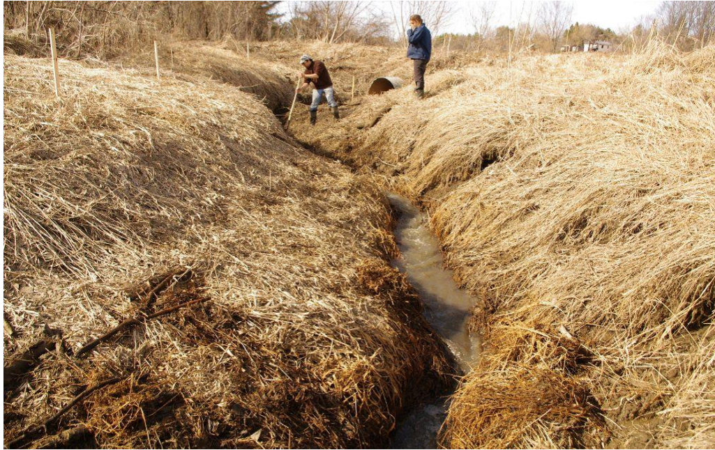
Photo 6 Marais I. Avant l'intervention, une forte pente longitudinale empêchait la libre circulation du poisson entre la rivière St-François et le marais.
